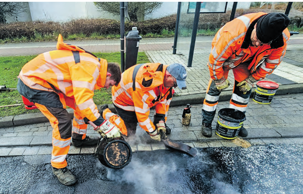
Teamwork: Während Christoph Selle den heißen Asphalt in das Schlaglocher gießt, verteilt Andrew Parker die Masse gleichmäßig und Achim Stallmann streut Splitt für eine bessere Griffigkeit.
