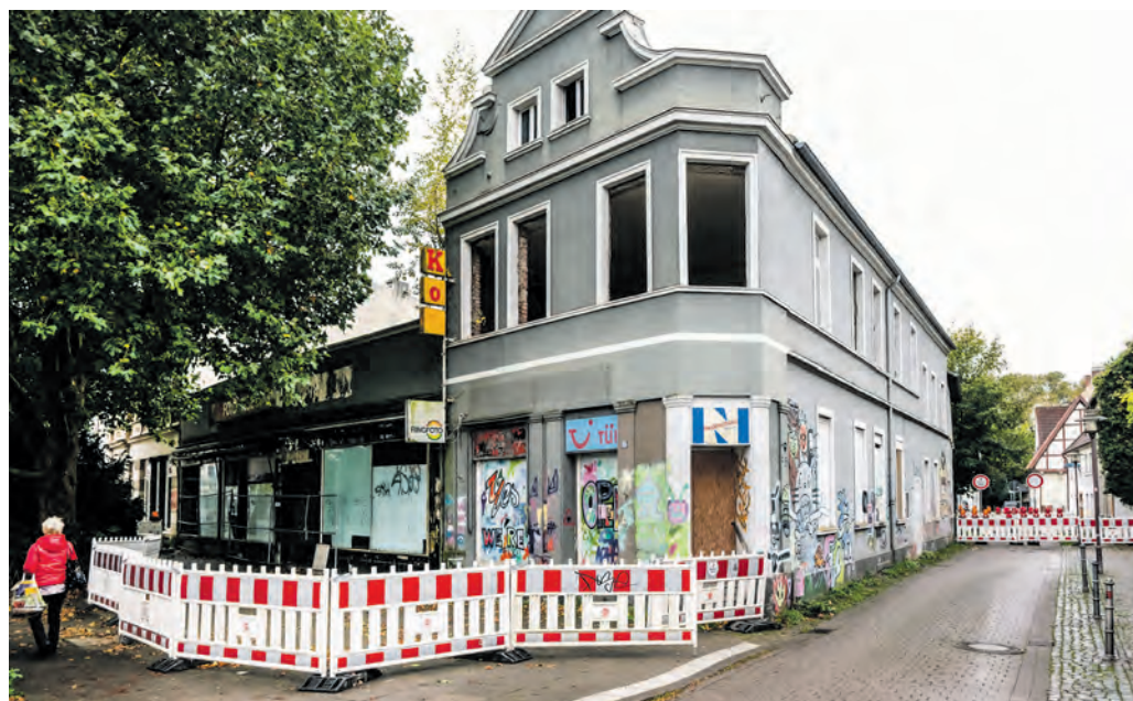
Akute Einsturzgefahr: Seit 2011 stehen das ehemalige Fotogeschäft Ilseemann und die darüber liegende Wohnungen leer. Nun wurde der Bereich um Herfords prominentesten Schandfleck aus Sicherheitsgründen dichtgemacht – auch für Fußgänger und Radfahrer.
