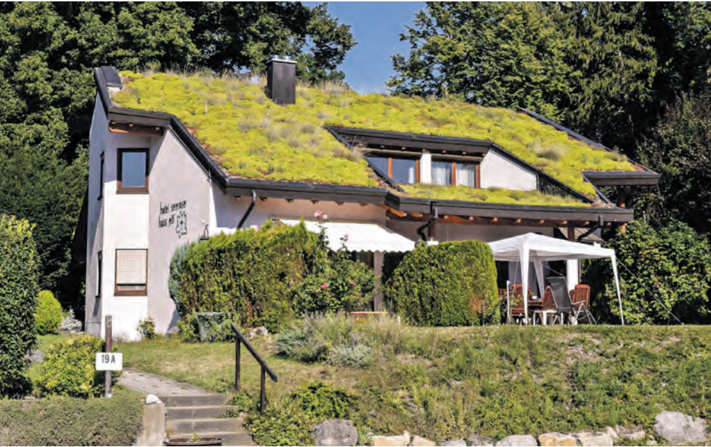
Dachbegrünungen tragen zum Klimaschutz bei: Sie binden CO 2 in der Vegetation und helfen durch Energieeinsparungen, Emissionen zu senken. Fotos: DJD/Bundesverband GebäudeGrün
