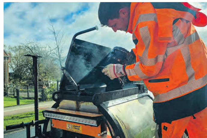
Die Heißgussasphalt-Masse ist bereit zum Einsatz und wird unmittelbar auf die Schadstelle aufgetragen.
