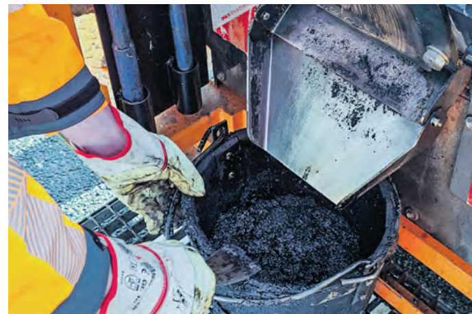
Zur Vorbereitung des Heißgussasphalts füllt Straßenwärter Christoph Selle nach und nach sogenannten Kaltasphalt in den E-Kocher.
