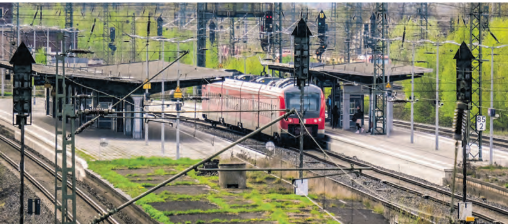
Ob Bahnhöfe, Gleisanlagen oder Haltestellen: Der regionale Nahverkehr weist einen großen Sanierungsstau auf. Der Zweckverband Nahverkehr Westfalen-Lippe will im nächsten Jahr rund 26 Millionen investieren.
