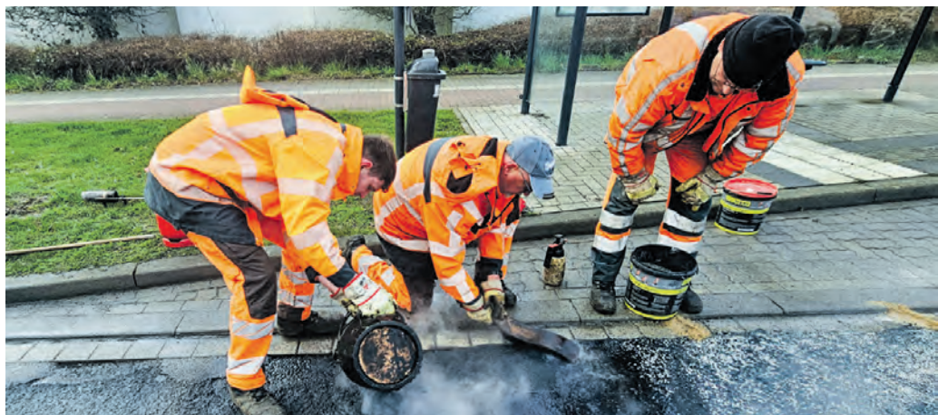
Teamwork: Während Christoph Selle den heißen Asphalt in das Schlaglocher gießt, verteilt Andrew Parker die Masse gleichmäßig und Achim Stallmann streut Splitt für eine bessere Griffigkeit.
