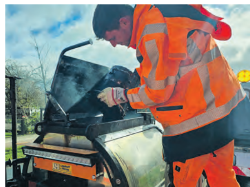
Die Heißgussasphalt-Masse ist bereit zum Einsatz und wird unmittelbar auf die Schadstelle aufgetragen.
