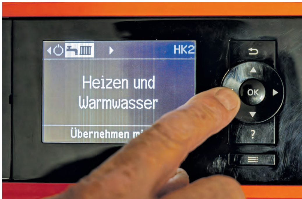
Heizen und Warmwasser aus dem Erdreich: Gerade bei der Altbau modernisierung bietet die Nutzung von Erdwärme viele Vorteile.
