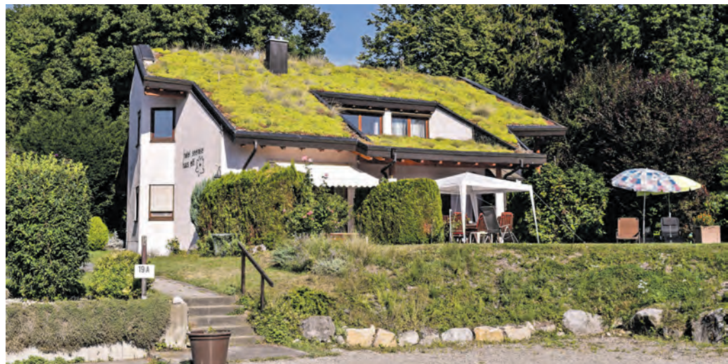
Dachbegrünungen tragen zum Klimaschutz bei: Sie binden CO 2 in der Vegetation und helfen durch Energieeinsparungen, Emissionen zu senken. Foto: DJD/Bundesverband GebäudeGrün
