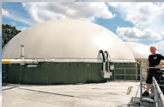
Auf dem Dach des beheizten Hauptgärers, auch Fermenter genannt, wo Bakterien die eingebrachten Inputstoffe unter Ausschluss von Sauerstoff zersetzen. Im Hintergrund ist das Endlager zu sehen.
