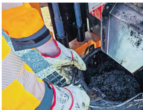
Zur Vorbereitung des Heißgussasphalts füllt Straßenwärter Christoph Selle nach und nach sogenannten Kaltasphalt in den E-Kocher.
