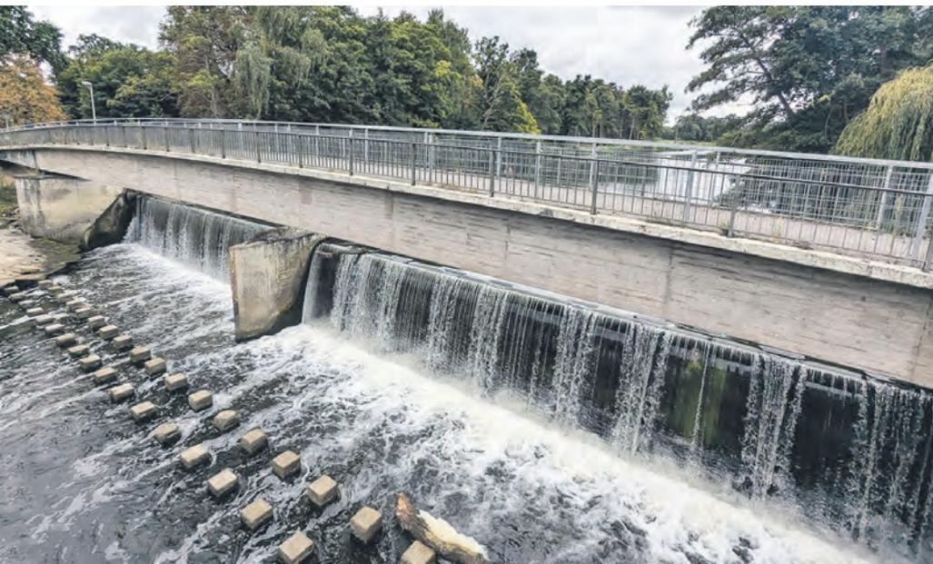
Die Tage des unermüdlich brausenden Sielwehrs und der alten Brücke sind gezählt. An dieser Stelle ist eine sogenannte „raue Gleite“ vorgesehen, die den Höhenunterschied überwinden und die Durchgängigkeit des Gewässers verbessern soll.
