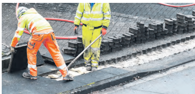
Vertrauter Anblick: Während die meisten Straßen in Herford bereits von Glasfaserleitungen durchzogen sind, müssen einige Außenbereiche auf die Bautrupps weiter warten.
