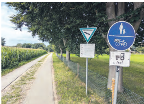
Vor 13 Jahren wurde der Abschnitt in dieser Form ausgebaut. Der Übergang zu den zwei schmalen Spuren mit der Schotterfläche in der Mitte ist deutlich zu erkennen.
