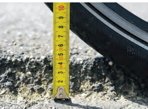
Gefahrenpotenzial: Die Höhe der Asphaltkante zwischen den beiden schmalen Fahrspuren und der mittigen Schotterfläche beträgt bis zu fünf Zentimeter.
